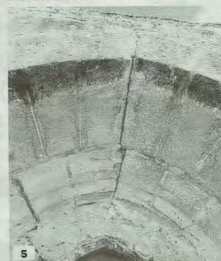
1. Aspecto actual de la fachada cubierta y protegida con el andamiaje. 2. Friso superior de la portada con el decorado de azulejos, en parte desprendido. 3. Un pequeño pino que ha echado raíces en las uniones de las piezas que conforman la cubierta en el edificio. 4. Vista cenital de la basílica y su entorno. 5. Detalle de una grieta que aparece en una de las ventanas que dan al interior. 6. Una de las imágenes de los santos mercedarios que figura en la fachada. 7. Rostro de la reproducción en piedra de Nuestra Señora de la Merced que se expone en la fachada FOTOS: MANUEL ARANDA
