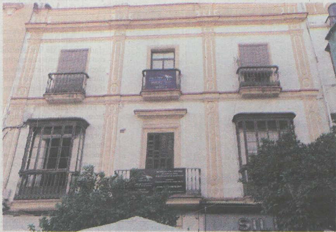
Imagen del edificio que va a ser rehabilitado y que acogerá cinco apartamentos turísticos. VIVA JEREZ
